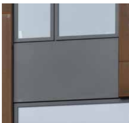
Kassett monterad på karm från fabrik
