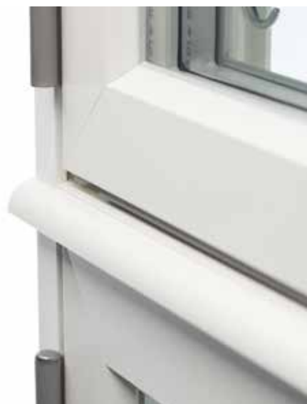
Droppnäsa och kittfals med tidstypiskt utseende
