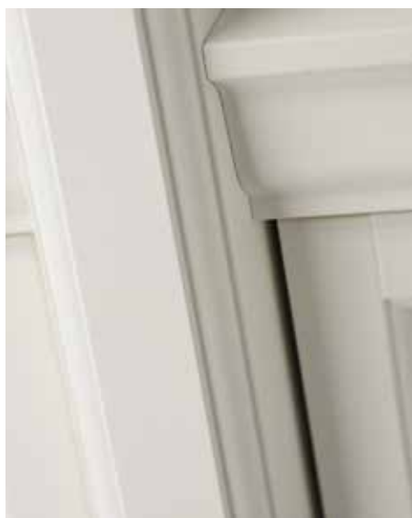
Asymmetrisk tvärpost och kvartstavsprofilerad lodpost
