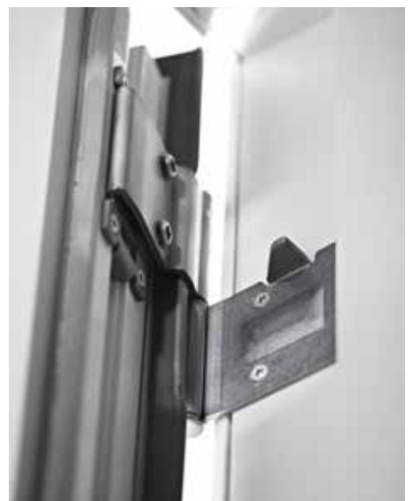
Inbyggt säkerhetspaket med extra kraftigt låssystem, förstärkta beslag och skruvar samt säkerhetslimmade glas.
