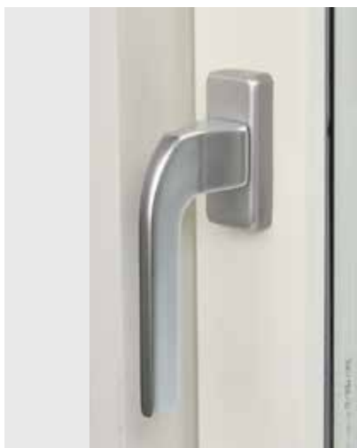
Invändigt spanjoletthandtag. Som standard monterat i alla öppningsfunktioner.
