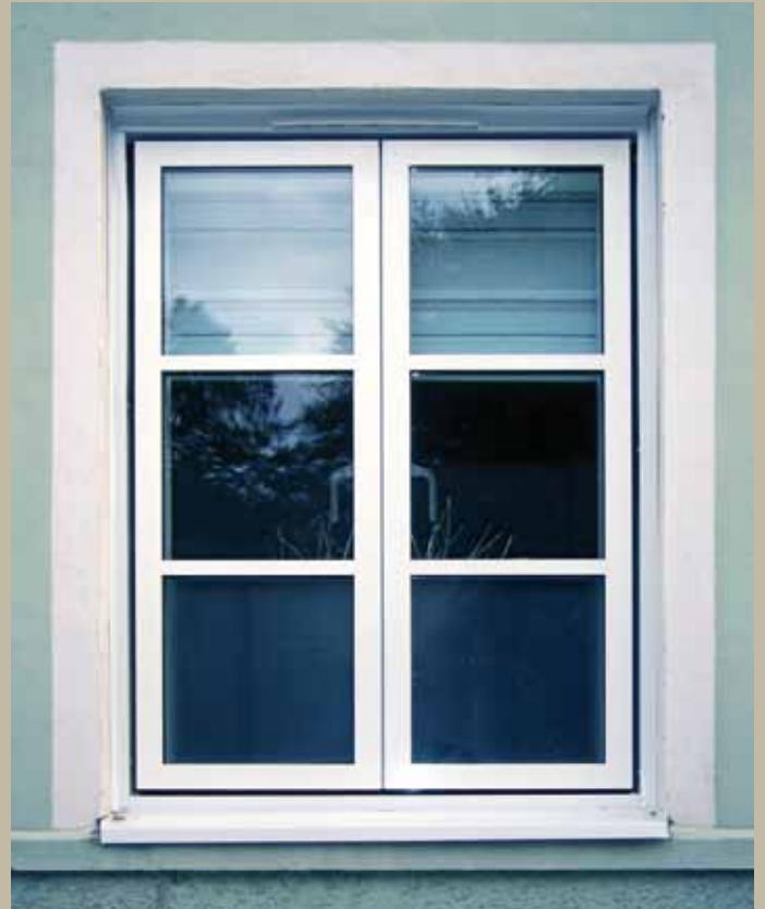
► Montage av VELFAC 200i i befintlig karm. Den gamla karmen har klätts med aluminium.
