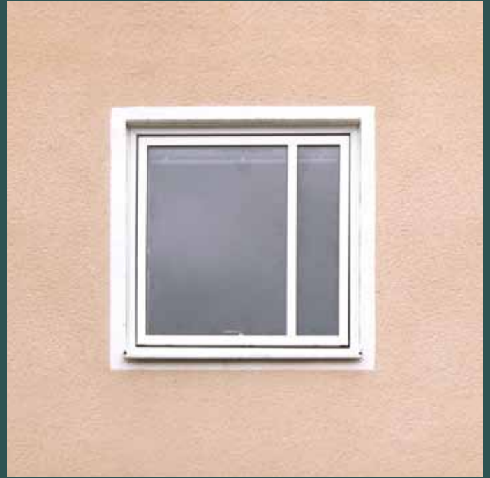
► Montage av VELFAC 200i i befintlig karm. Den gamla karmen har klätts med aluminium.
